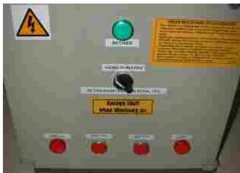
Двигатель включается и через 3 сек переключается со «звезды» на «треугольник».
